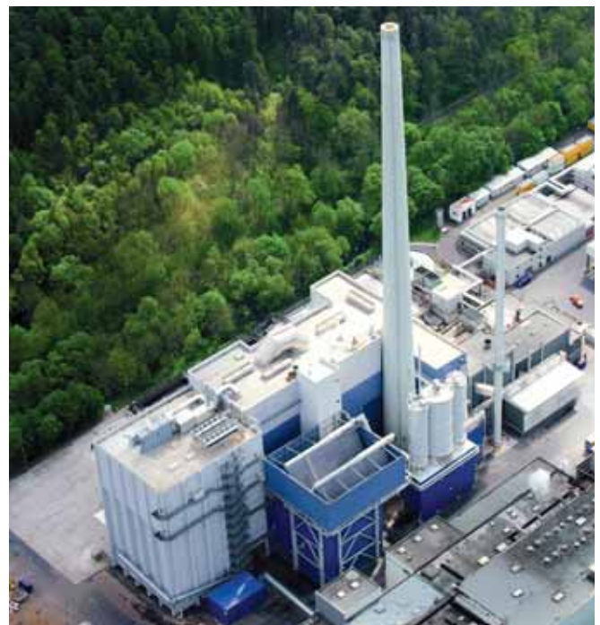
EBS-Kraftwerk bei SCA Packaging; Foto: B+T Energie und SCA
